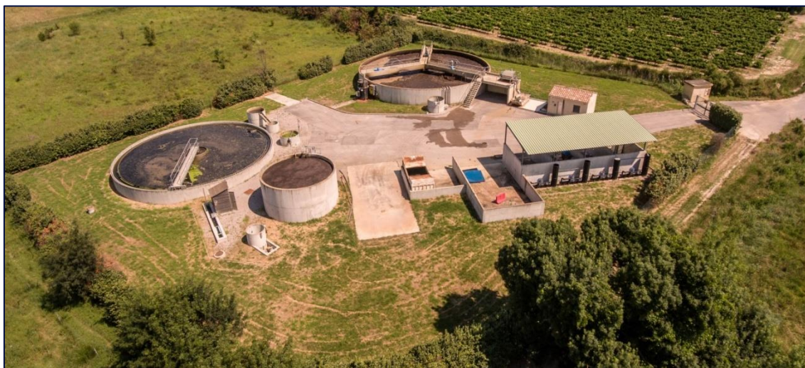
Figure 2 : Station d'épuration de Lavérune
