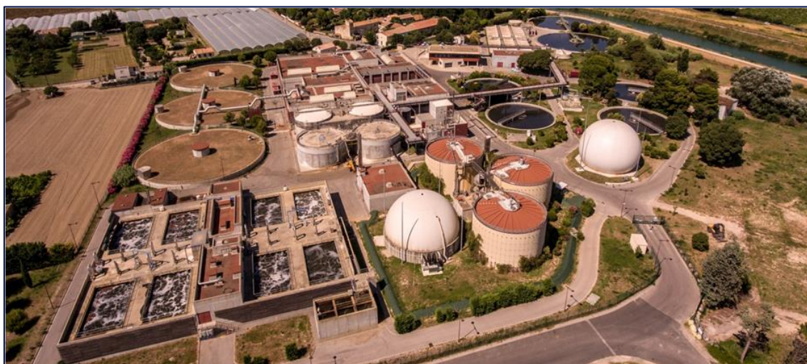
Figure 2 : Station d'épuration de Maera
