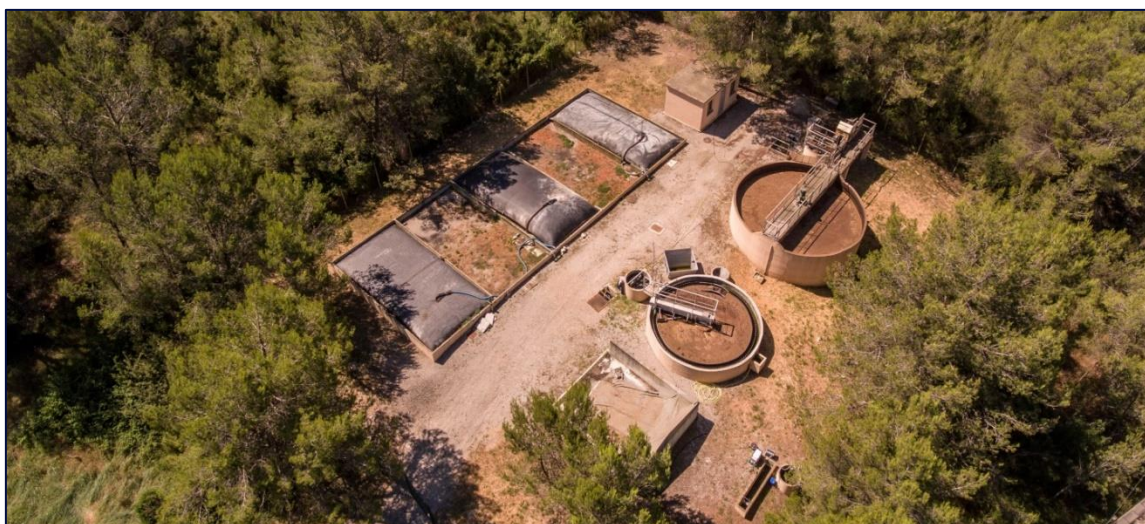
Figure 2 : Station d'épuration de Montaud
