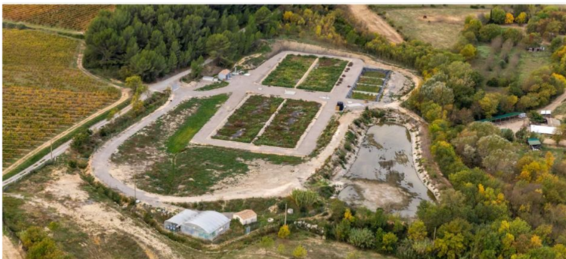
Figure 2 : Station d'épuration de Murviel-lès-Montpellier
