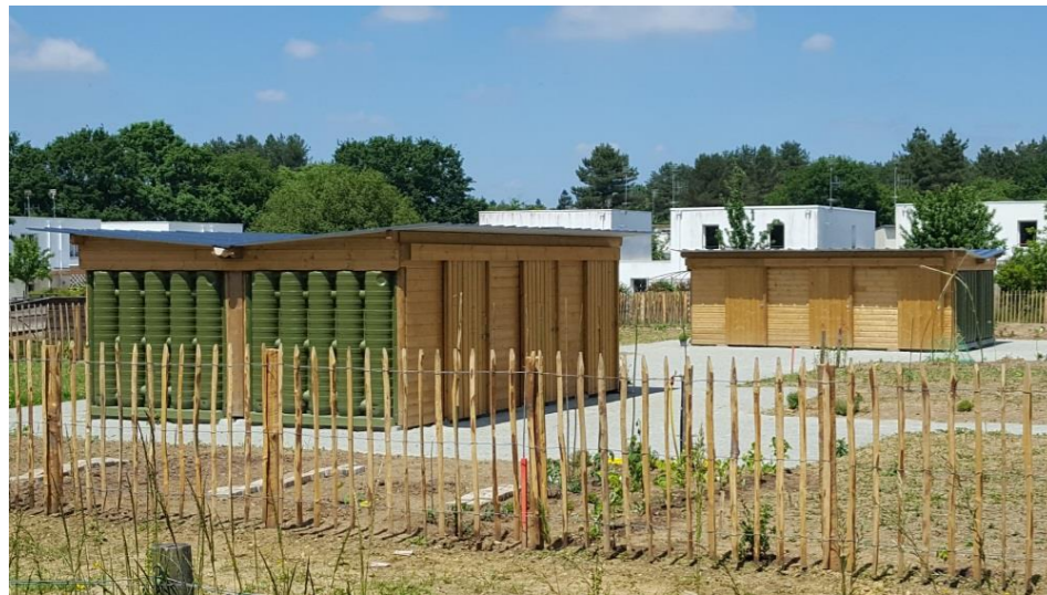
Exemple de récupérateur d'eau de pluie intégré à la structure
