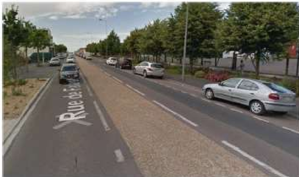
Photographie 9 : "Vue de l'aménagement Rue de Falaise (source : Street view Google)"
