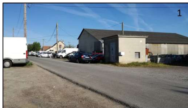
Vue sur un transformateur puis sur un commerce de voitures
