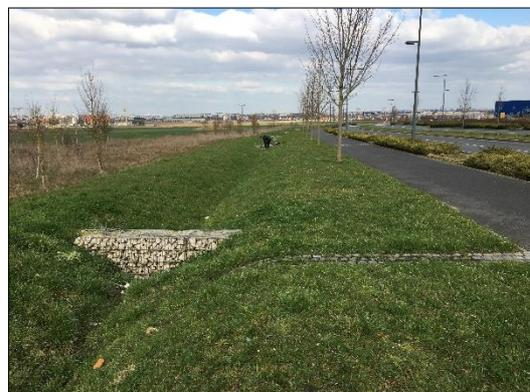
La noue réalisée en rive Ouest est compartimentée par des gabions d'une hauteur de 0,50 m, avec une largeur de 0,60 m en fond de noue et 3 m en crête. Elle constitue une capacité de stockage de 172 m<sup>3</sup>, se répartissant en 102 m<sup>3</sup> pour le tronçon Sud et 70 m<sup>3</sup> pour le tronçon Nord.
