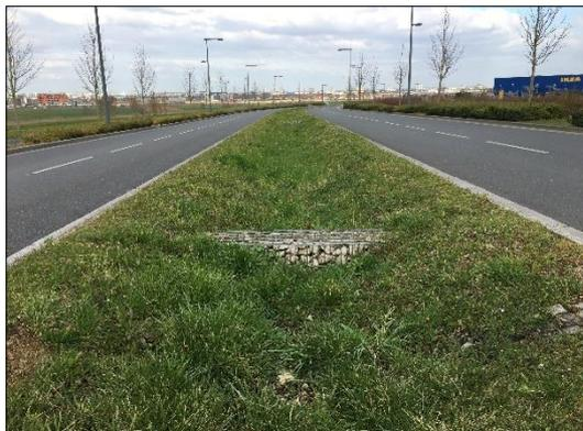
La noue réalisée dans le terre-plein central est compartimentée par des gabions d'une hauteur de 0,30 m, avec une largeur de 0,60 m en fond de noue et 2,00 m en crête. Elle constitue une capacité de stockage de 44 m<sup>3</sup>
