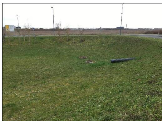
Le bassin réalisé au centre du giratoire central, bien que présentant une profondeur importante (près de 1,60 m au point bas de l'anneau de voirie périphérique) ne peut, en fait stocker que peu d'eau dans la mesure où le trop-plein est situé à 0,20 m au-dessus du fond. Le fond du bassin présente une superficie de 255 m<sup>2</sup>. Il offre donc, en l'état, une capacité de stockage de 51 m<sup>3</sup>.
