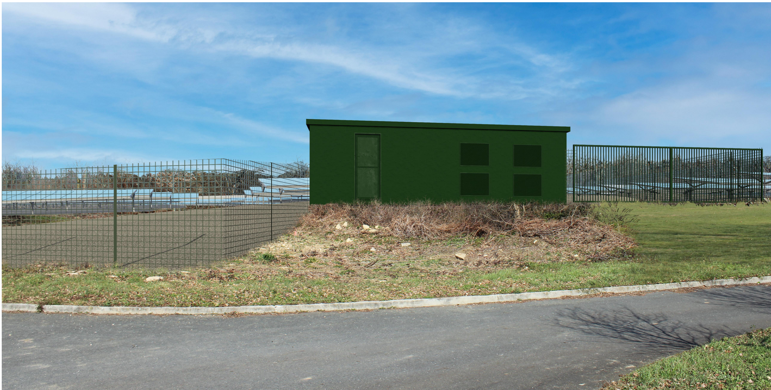
Point de vue n°3- Insertion Vue depuis l'entrée de la zone Ouest du projet
