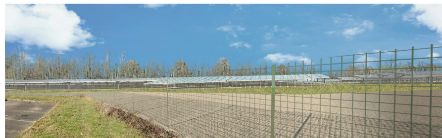
Insertion Vue depuis la station d'épuration - Source : Étude d'impact ETEN Environnement
