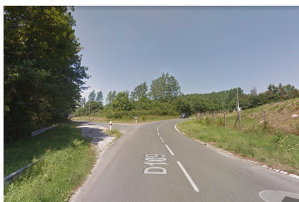
Accès sud du site depuis la RD109
