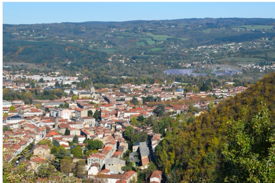
Vue sur la centrale depuis les hauteurs de la Montagne Noire
