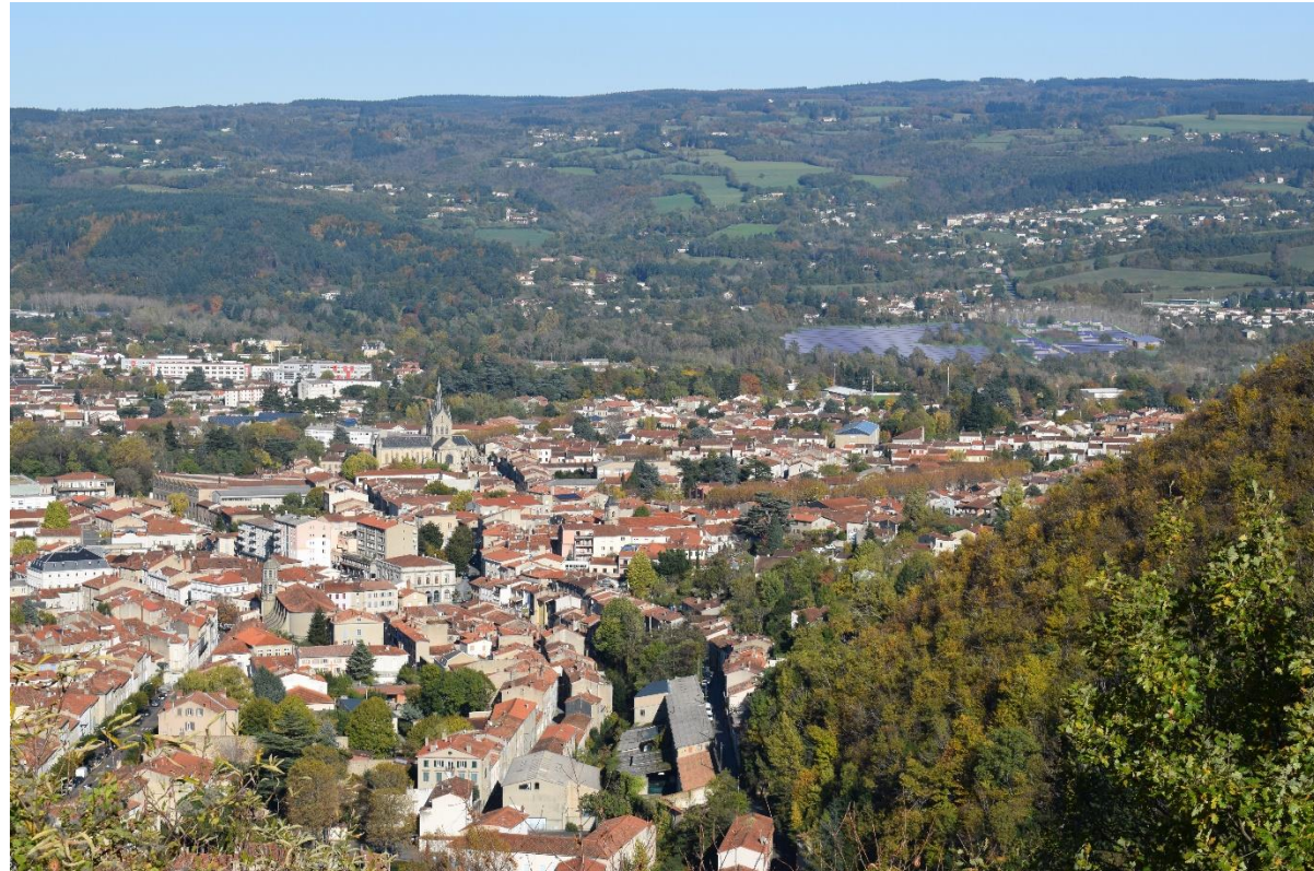
Vue sur la centrale depuis la D53 à Mazamet
