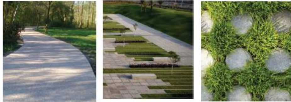
Trottoir béton (à gauche), alternance dalle béton/végétal (au centre) et espace de stationnement dalles engazonnées (à droite)
