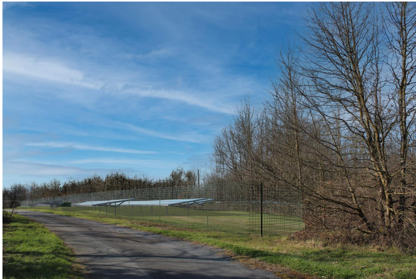
Point de vue n°5 : Insertion Vue depuis la limite Est du projet
