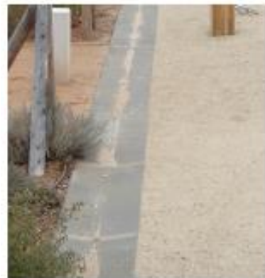
Exemple de sol en stabilisé clair
