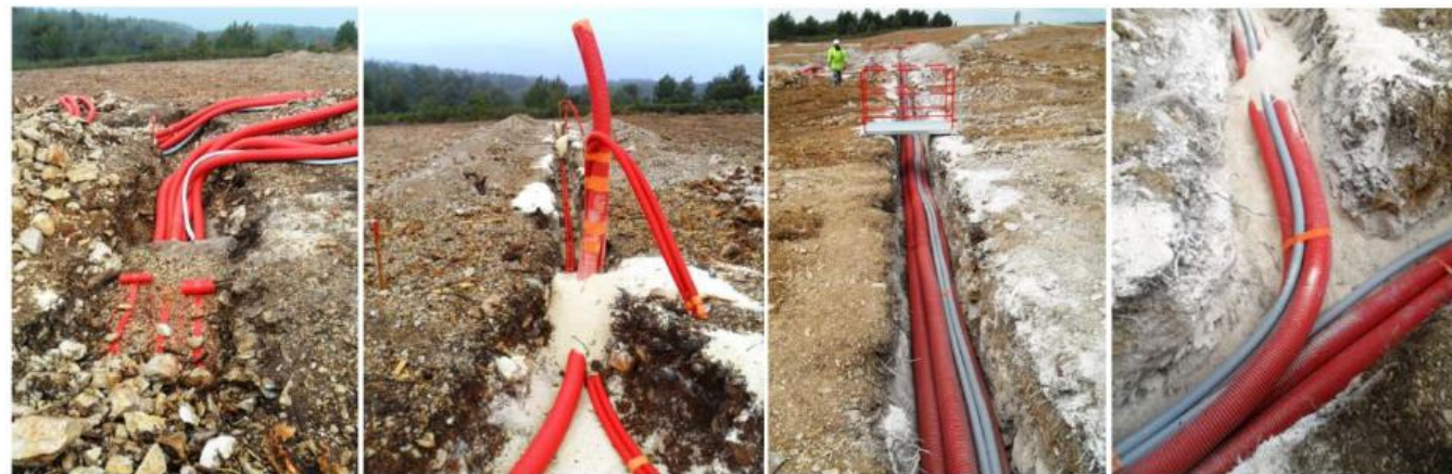
Photographie de travaux de création de tranchées
