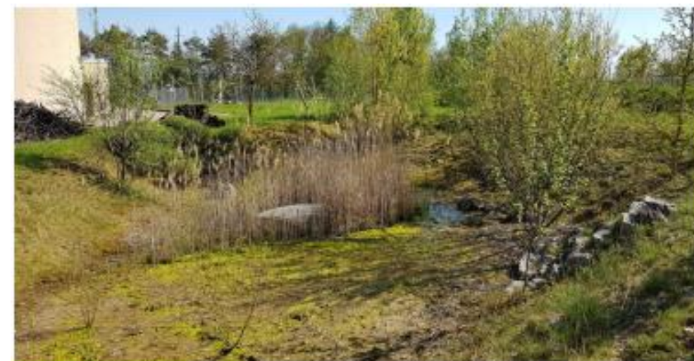
Exemple de bassin de rétention présentant une bonne valeur biologique et paysagère sur la commune de Nyon (© Atelier Nature et Paysage)
