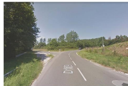
Accès sud du site depuis la RD109
