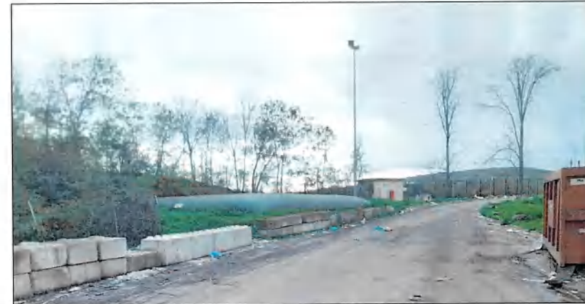
▲ Vue 3 - Cuve incendie
