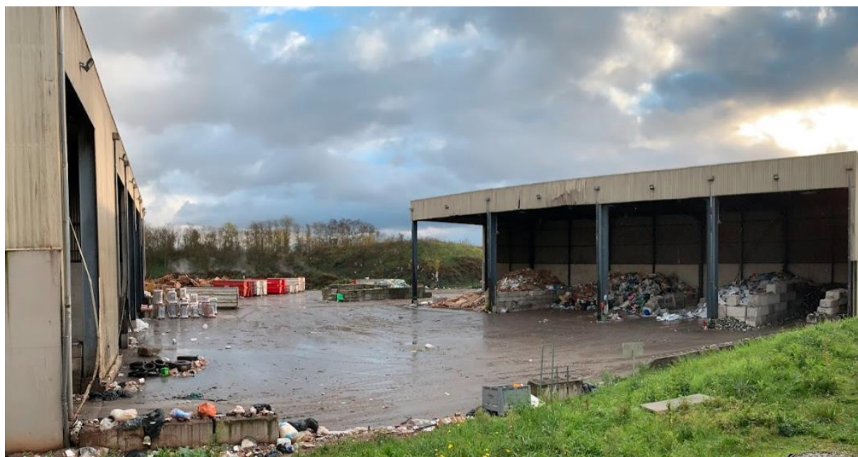
Photo 1: vue de la zone d'implantation du nouveau hangar reliant les deux hangars existants.
