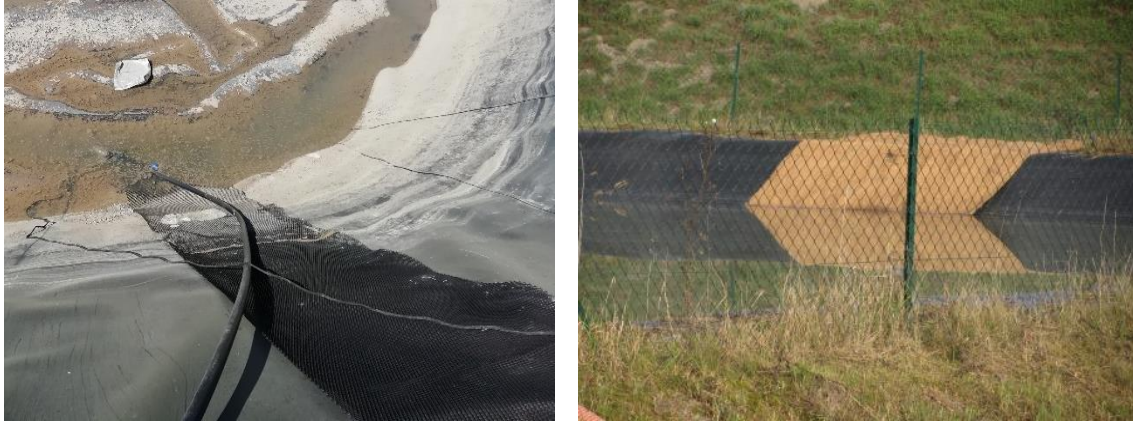
Photo 14 et suivante : Echappatoires pour la petite faune dans des « bassins incendies » (Ecolor, 2019).
