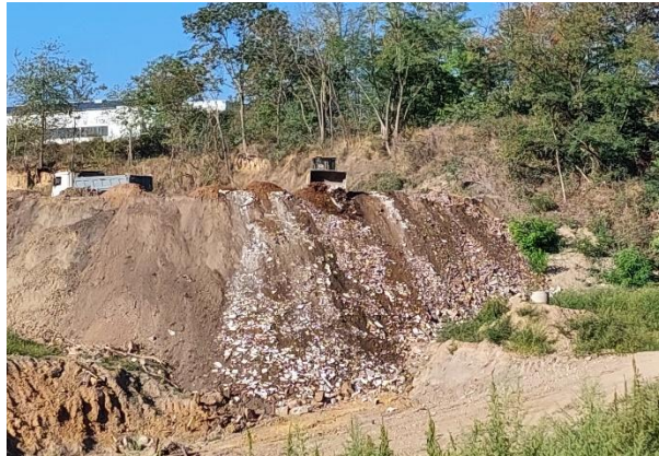
Photo 15: constitution d'un « quai de vidage » des gravats pour limiter la circulation des camions sur la zone sensible.
