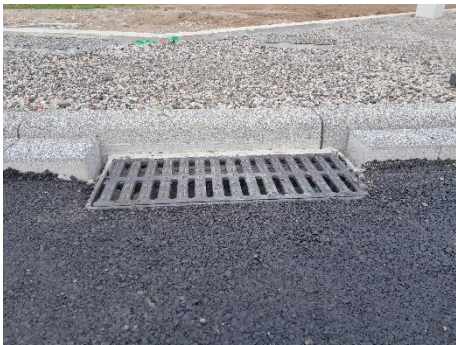
Photo 13: Exemple d'avaloir non sécurisé : les amphibiens parvenus sur la chaussée longent le rebord du trottoir et chutent dans le regard.
