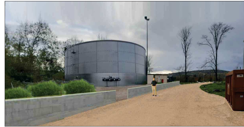
▲ Vue 3 - Cuve incendie
