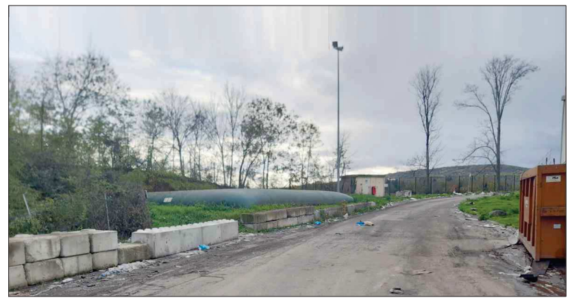
▲ Vue 3 - Cuve incendie
