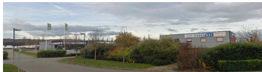
Vue sur la zone d'activité du Rosenmeer - bâti existant
