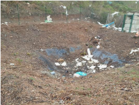
Photo 8 et suivantes : Bassins de rétention 1, 2 et 3.
