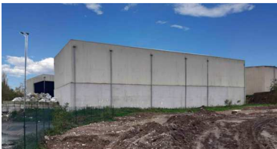
Vue arrière du bâtiment de stockage des déchets
