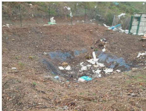
Photo 2 et suivante : Bassins de rétention 1, 2 et 3.
