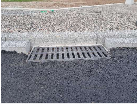
Figure 4: Exemple d'avaloir non sécurisé : les amphibiens parvenus sur la chaussée longent le rebord du trottoir et chutent dans le regard.
