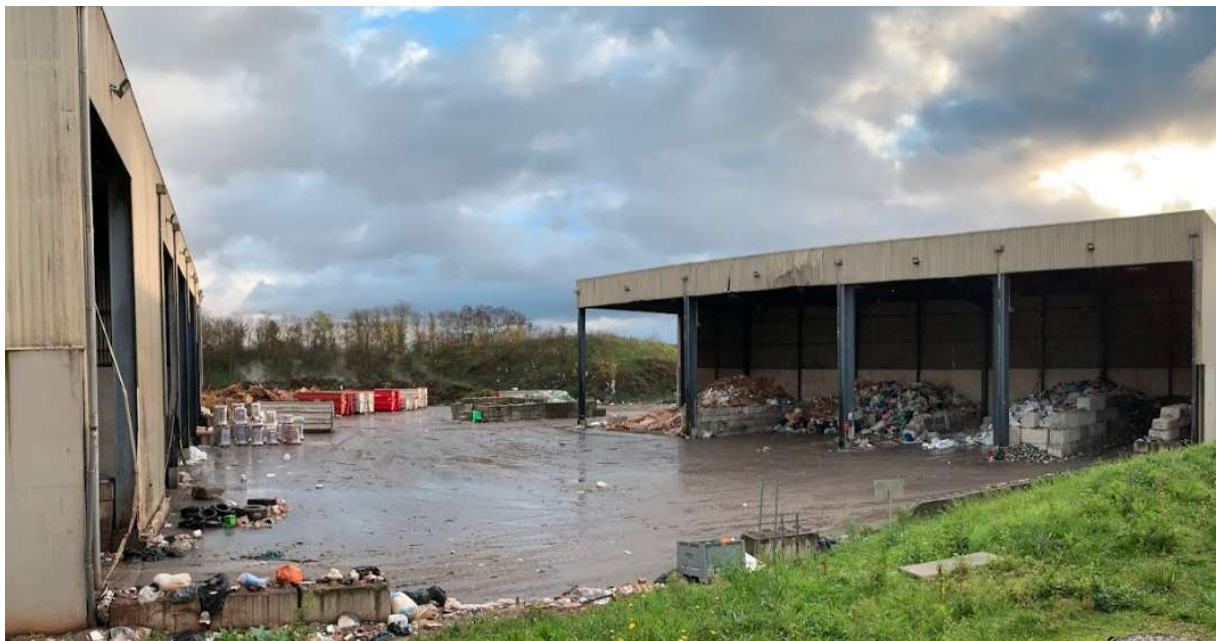
Photo 1 : vue de la zone d'implantation du nouveau hangar reliant les deux hangars existants.
