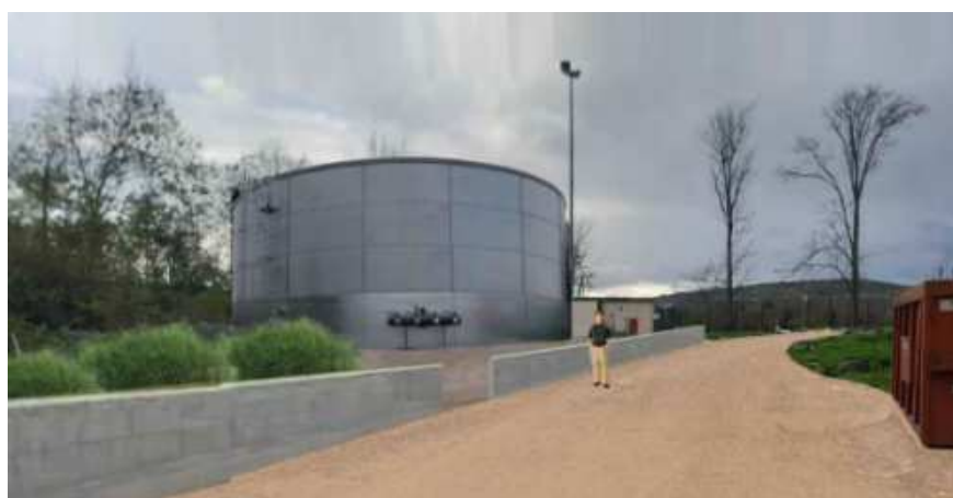
Création d'une cuve incendie
