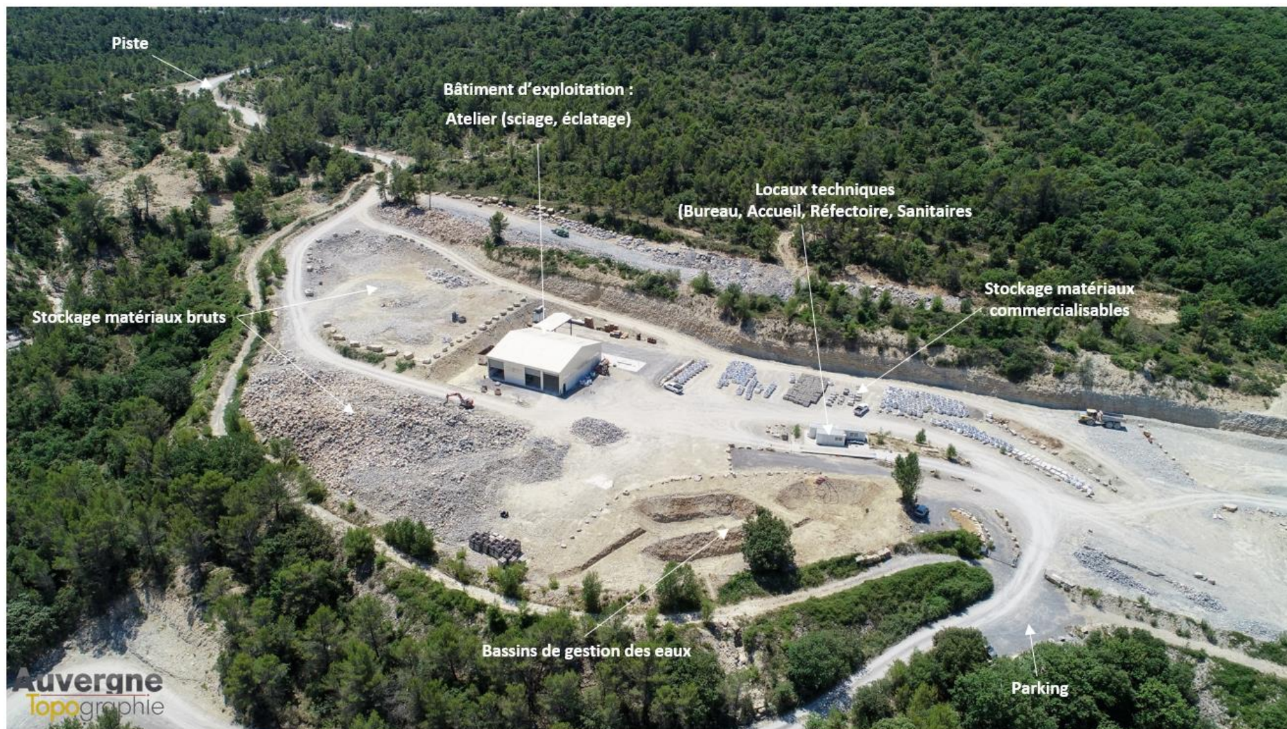
Secteur Nord : Plateforme technique
