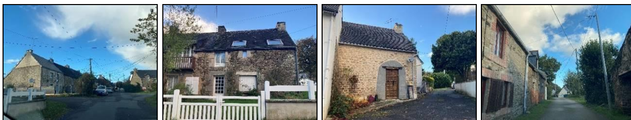
Photographies de bâtisses du hameau de Brancillet.
