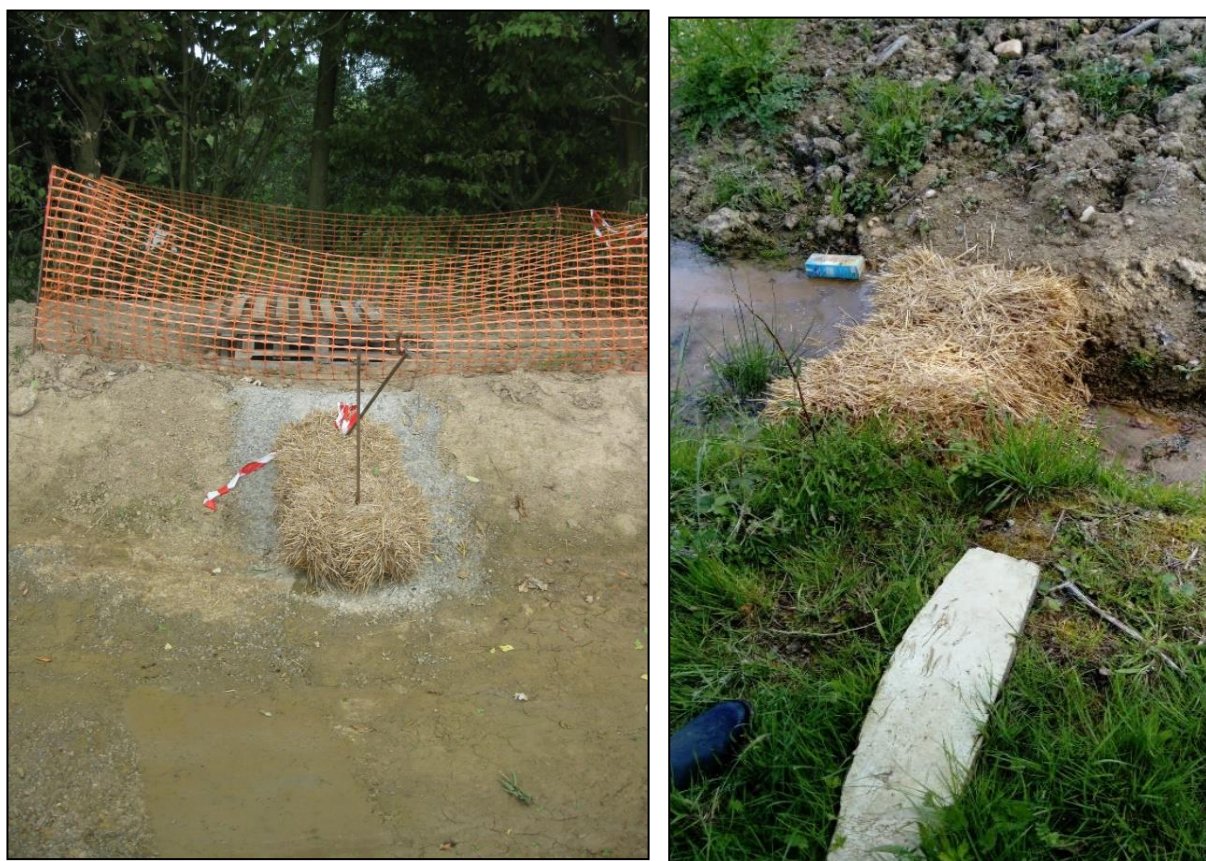
Figure 37 : Emplacements du filtre à particules fines (botte de paille) pendant la phase des travaux au niveau du bassin d'orage
