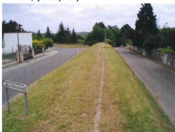
Ancien talus de l'Arpajonnais, rue des Petits Prés [PA-27]
