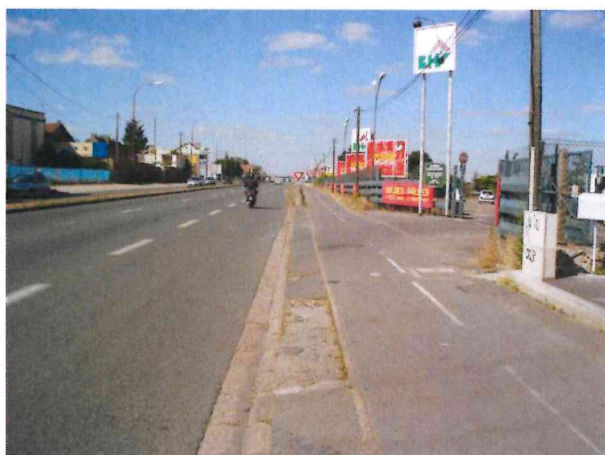
Sur l'accotement de la D 2020 [PA-52]
