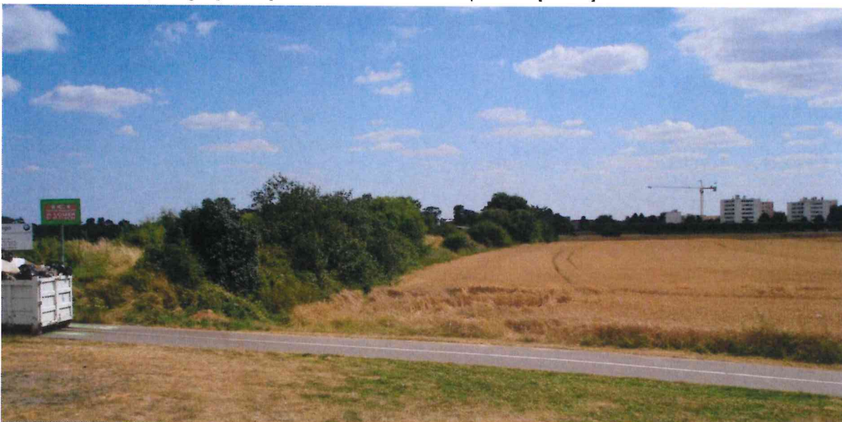
Voie sur remblai, envahie de végétation, en direction de Morangis [PA-04]
