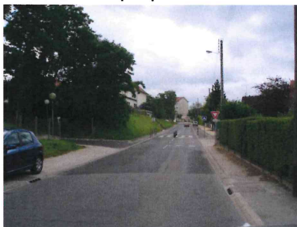
Connection avec le CGB Arpajon-Etampes, rue Demange [PA-48]
