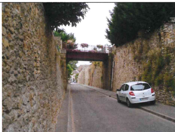
Ancienne tranchée, rue de l'Arpajonnais [PA-22]
