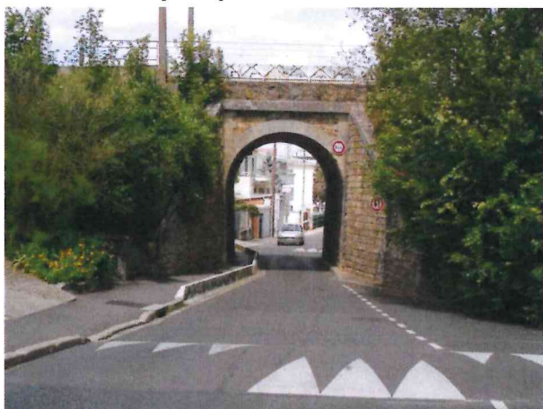
Passage sous la ligne Paris-Orléans, rue du Dr Verdié [PA-49]
