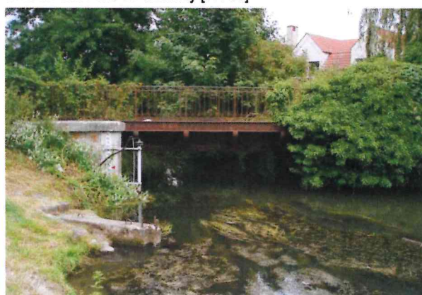
Moulin d'Aulnay, vestige de pont ferroviaire sur l'Orge [PA-38]
