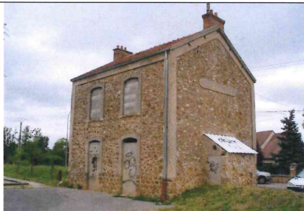
Ancienne station de Leuville [PA-32]
