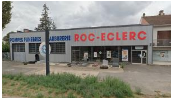
Enseigne sur bâtiment disproportionnée par rapport à la façade commerciale.
