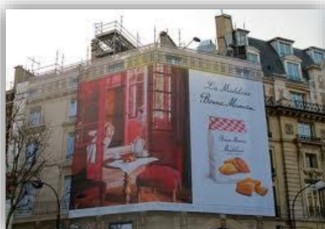
Publicité sur bâche de chantier
