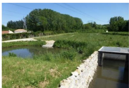
Bassin de dépollution naturelle
