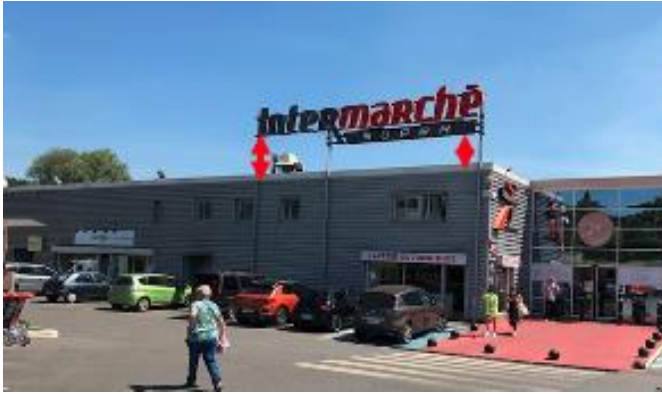
Enseignes sur toiture en infraction au RNP : Pas de panneau de fond dissimulant les supports de base dont la hauteur est limitée à 0,50 m.
