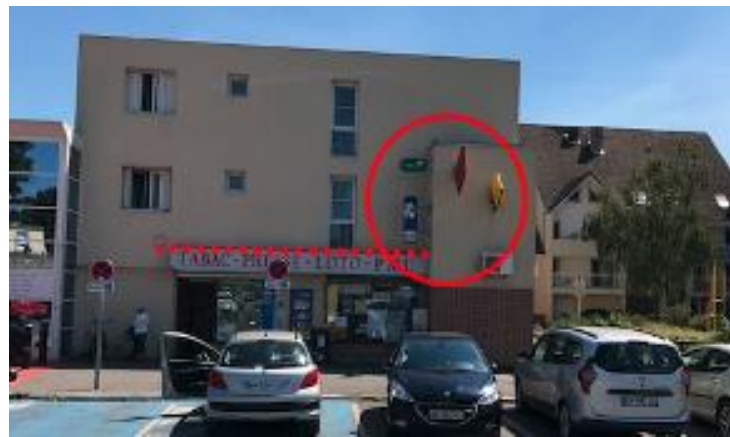
Enseignes en drapeau implantées au niveau R+1 d'un bâtiment d'habitation où s'exerce une activité en rez-de-chaussée.
