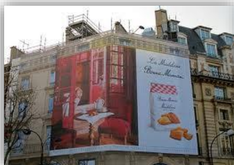
Publicité sur bâche de chantier
