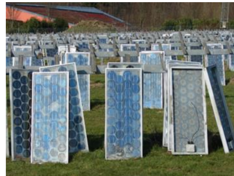
Figure 81 : Panneaux photovoltaïques en fin de vie (source : Soren, 2015)
