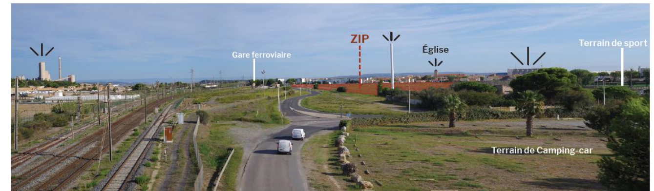
Figure 38 : Vue depuis l'Avenue du Général de Gaulle, au sud de la ZIP.
