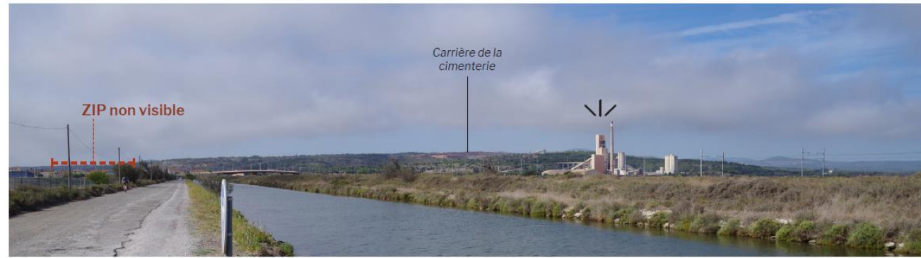
Figure 35 : Vue depuis le canal de la Robine vers Port-la-Nouvelle, la Cimenterie et le Piémont de garrigue. ZIP non visible.
