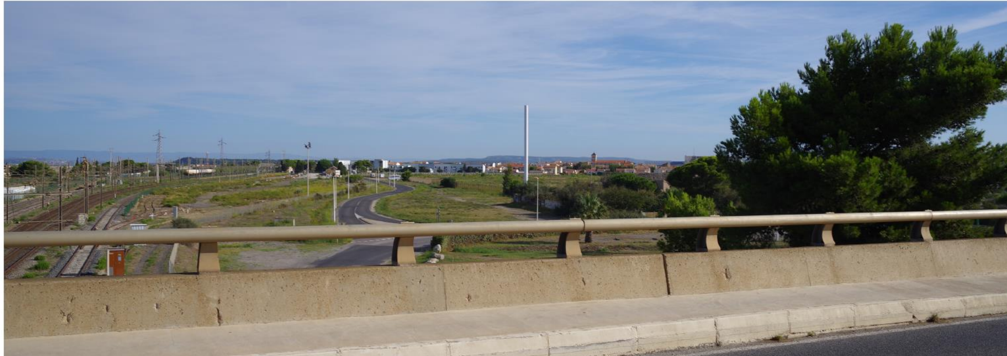
Figure 86 : Vue 2 - état initial
