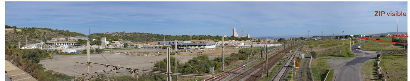
Figure 30 : Panorama de la Zone d'activité entre la ZIP et le Piémont de Garrigue.
