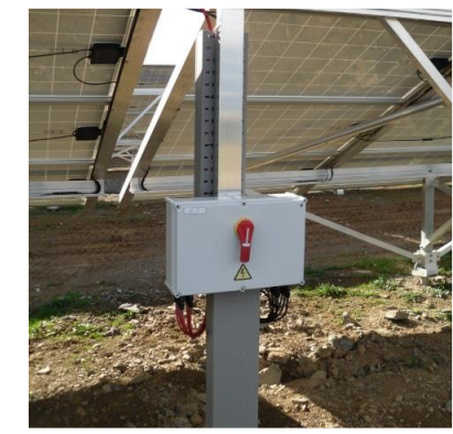
Photo 16. Boîtier de raccordement 20
