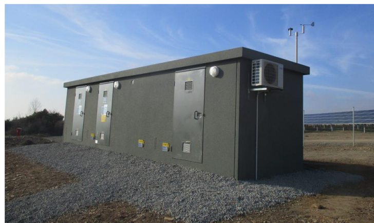
Photo 9. Exemple de structure de livraison 14
