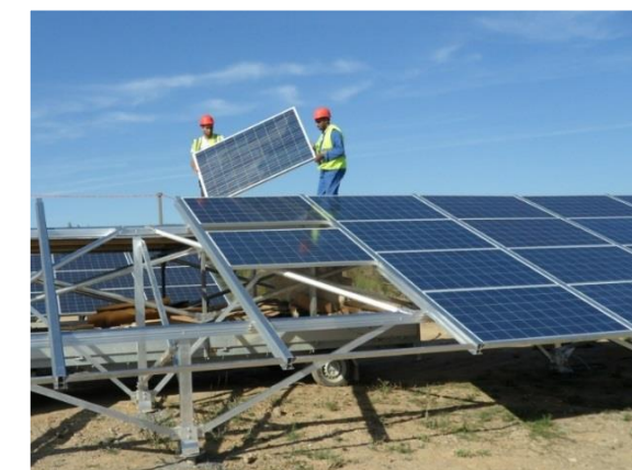
Photo 13. Exemple de mise en place des panneaux sur les structures 18
