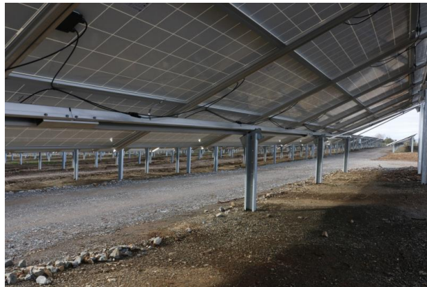
Photo 11. Exemple de pistes empierrées 16
