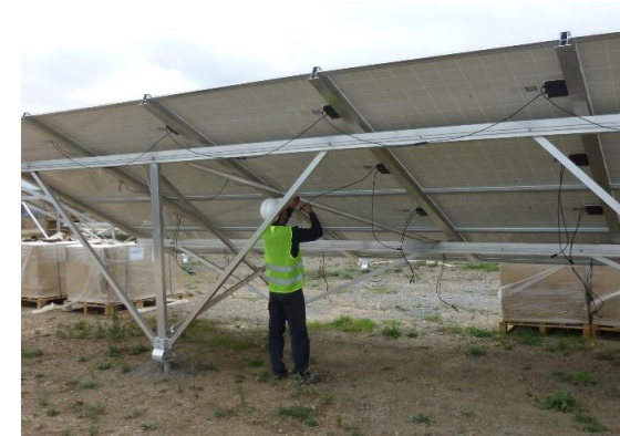
Photo 15. Câblage des panneaux 19
