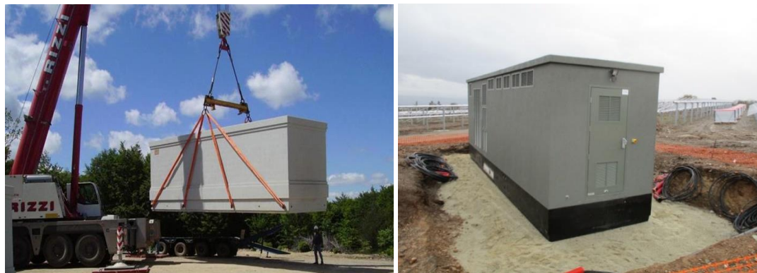
Photo 14. Installation d'un poste électrique
