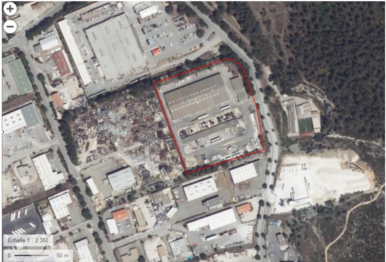
Environnement du site.
