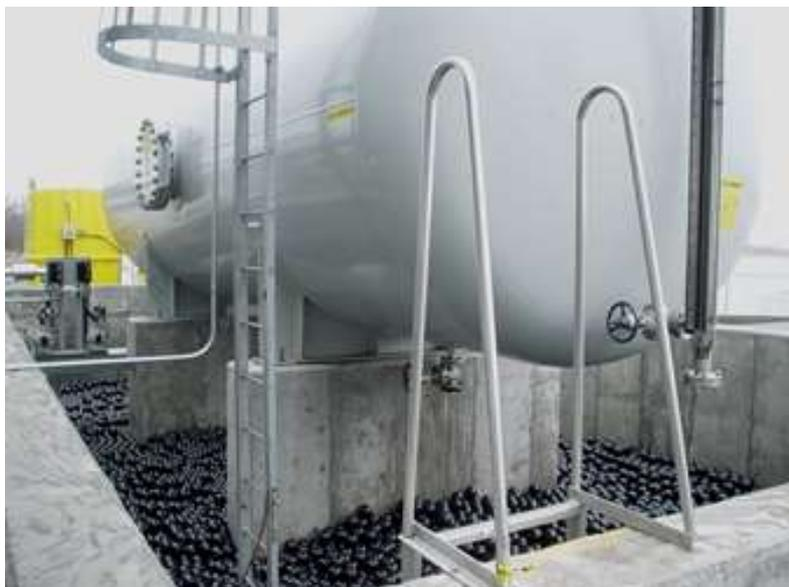
*Exemple de couverture de rétention sur une installation chimique.*
