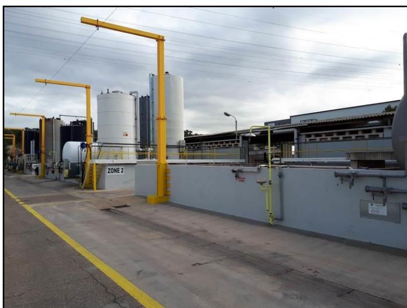
Deux tours de lavage sont situées à proximité de la cuverie afin de « laver » les vapeurs de chlorure d'hydrogène émises lors des opérations de remplissage des cuves d'acide chlorhydrique. L'acide chlorhydrique est mis en contact avec l'eau. Ces équipements rejettent un mélange aqueux d'eau et d'acide chlorhydrique.
