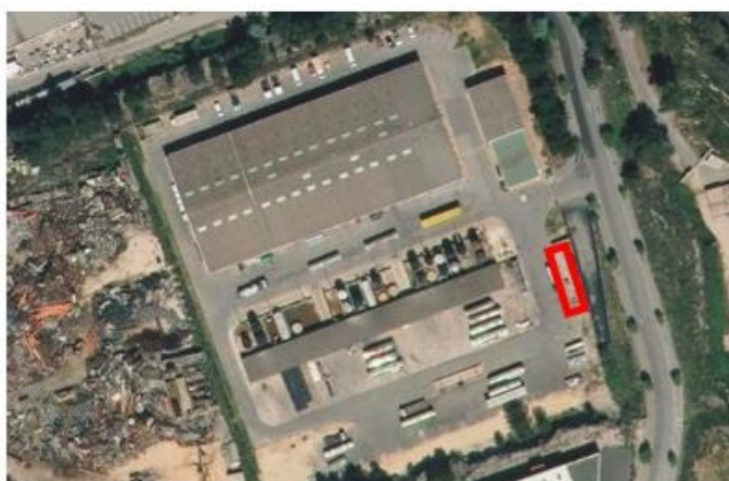
Emplacement prévu pour la future station carburant.
