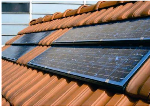
Figure 30 - Intégration de toiture
