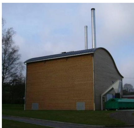
Figure 44 : Chaufferie bois de Saint Hilaire du Harcouet (50) (Source : les 7 Vents du Cotentin)
