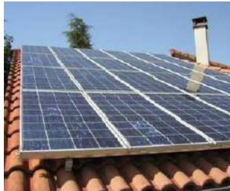
Figure 29 - Panneaux solaires en surimposition
