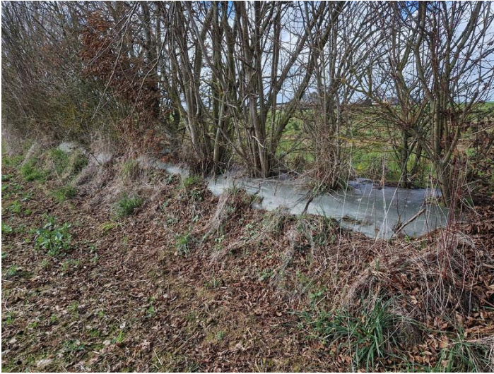
Vue sur le talus bâché
