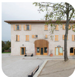
© V. Rigassi - Logements sociaux et commerces - Montseveroux (38)
