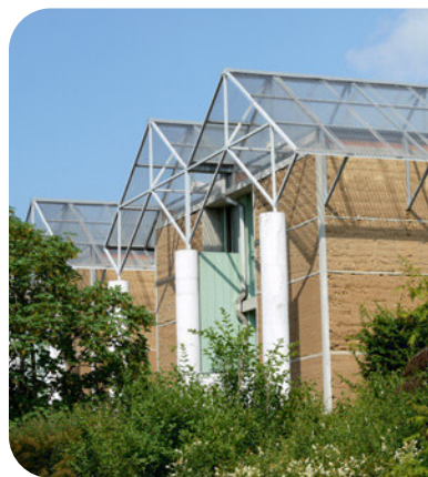
© CRAterre, T. Joffroy - Mur en terre
