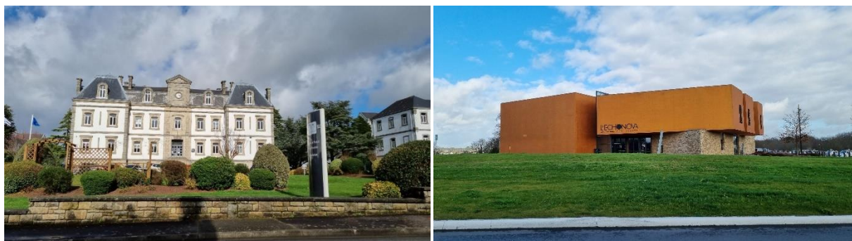
Hôpital de Saint-Avé à Lesvellec et l'Echonova (Source : 2AD)
