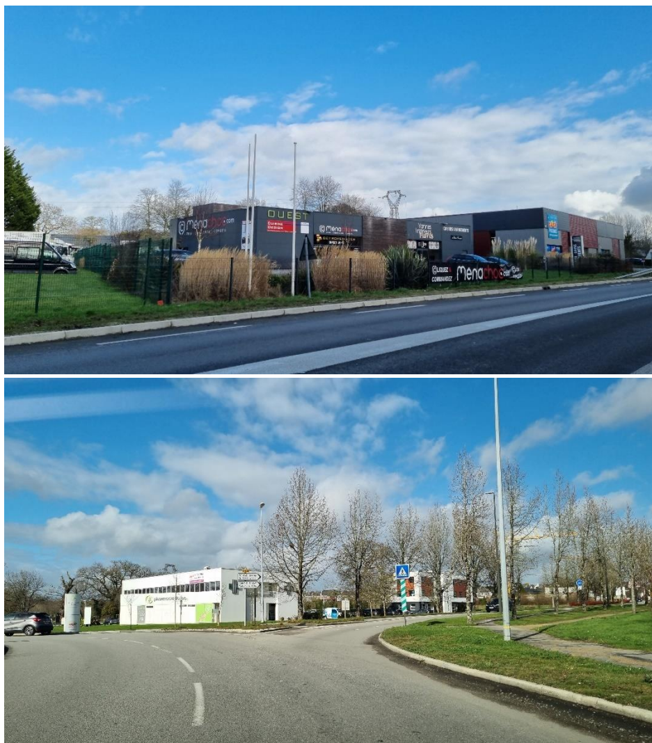
Le bâti lié à l'activité économique et les alignements d'arbres le long des routes (Source : 2AD)
