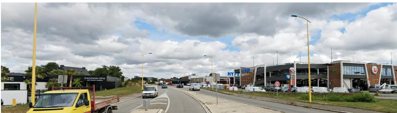
Entrée urbaine dégradée (Source : 2AD)
