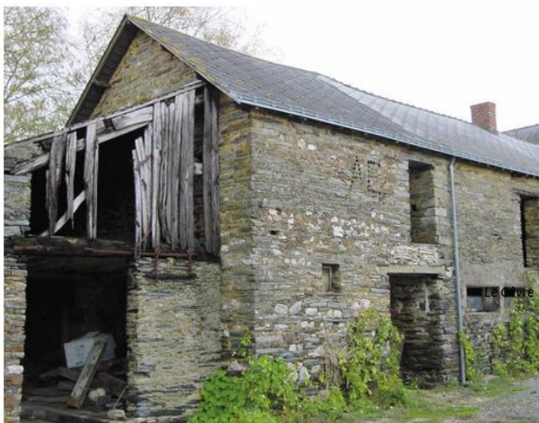
Le corps de ferme avant travaux
