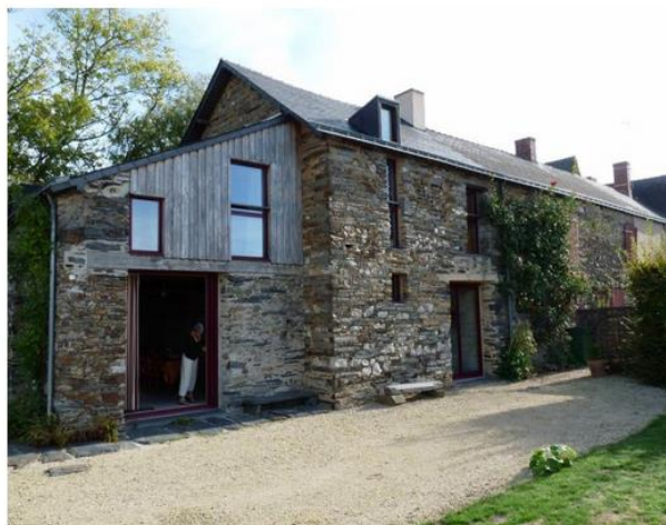
Le corps de ferme après travaux. © L'atelier Belenfant-Daubas, architectes
