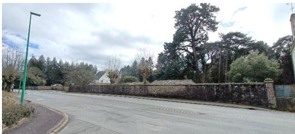
Mur à préserver
