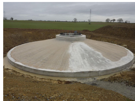
PHOTOGRAPHIE D'UNE FONDATION D'ÉOLIENNE
