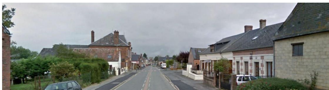
RUE DE VERDUN À MONCEAU-LE-NEUF, AVANT (HAUT) ET APRÈS (BAS) ENFOUISSEMENT DES RÉSEAUX (SOURCE : ATELIER DE L'ISTHME)
