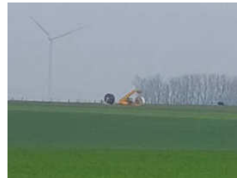
Passage de câbles à la trancheuse
