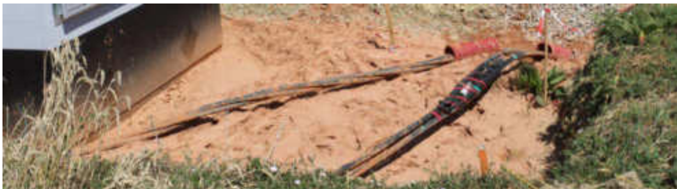
Photo 12 : Câbles souterrains reliant les éoliennes au poste de livraison avant enfouissement (Source : Ora environnement)
