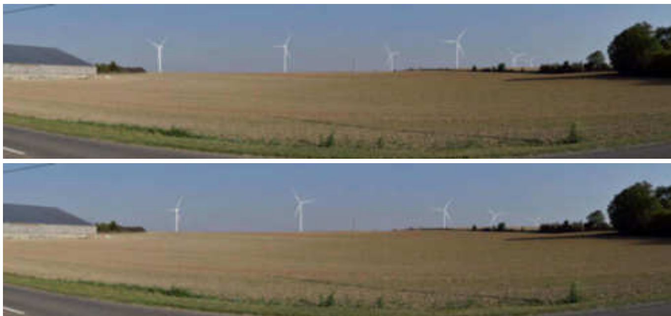
Photo 20 : Variante A (haut) et variante B (bas) depuis la D967 à la sortie nord de Monceau-le-Neuf (Source : Atelier de l'Isthme)
