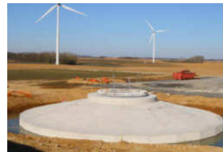
Photo 9 : Fondation avant recouvrement (Source : Ora environnement)
