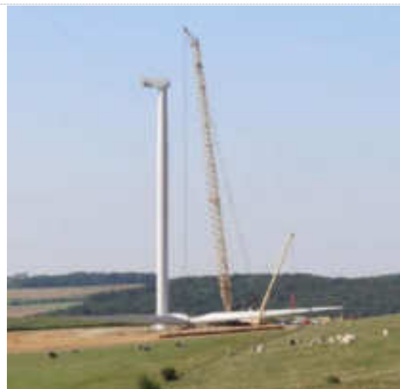
Photo 15 : Rotor assemblé au sol avant levage (Source : Ora environnement)
