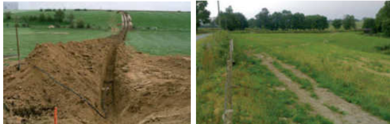
Photo 11 : Exemple de tranchée ouverte et de tranchée fermée depuis 2 mois (Source : Ora environnement)
