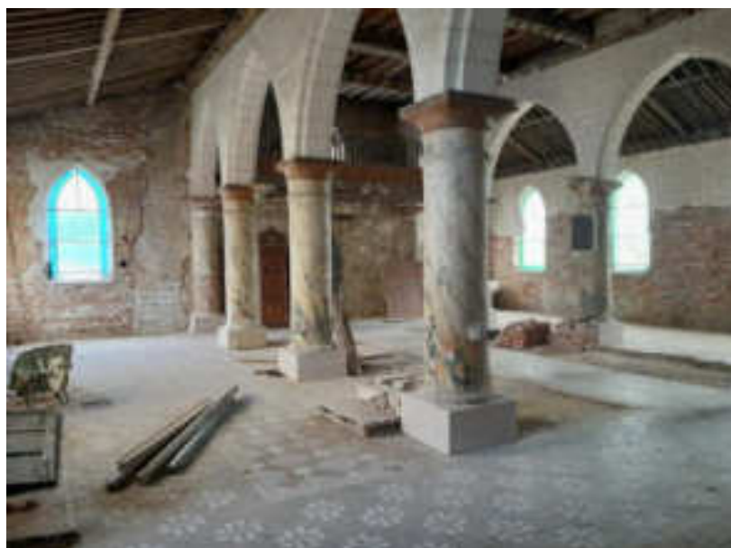
Figure 25. Eglise Saint-Rémi de Bois-lès-Pargny - T. Kestel, Ecosphère.
