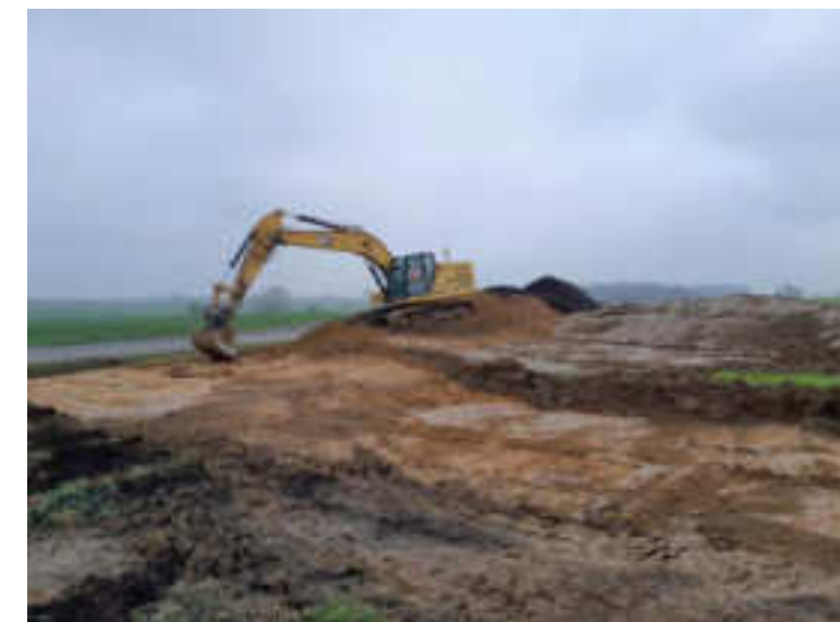
Dégagement d'emprise en phase chantier
