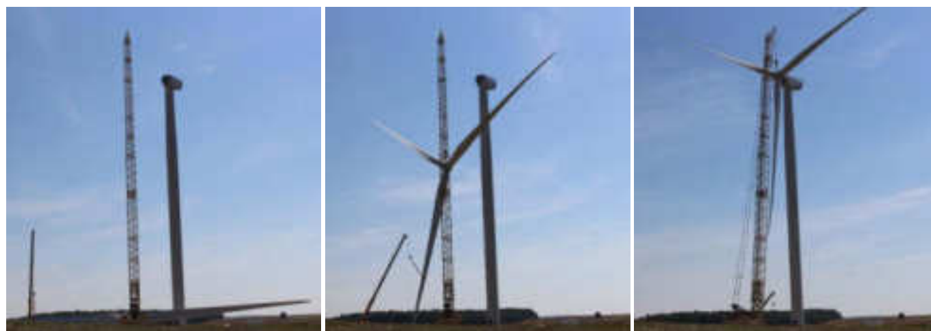
Photo 16 : Etapes du montage du rotor d'éolienne (Source : Ora environnement)
