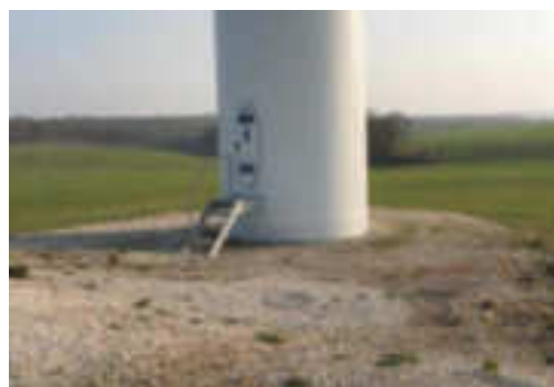
Photo 28 : Exemple de plateforme avec assainissement (Source : wpd onshore France)
