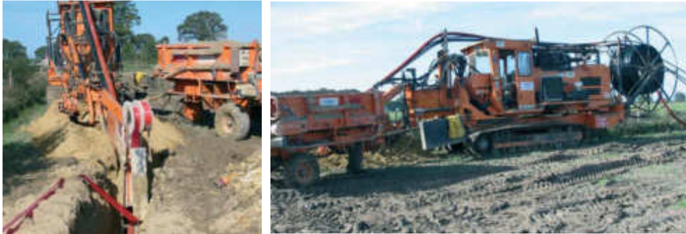
Photo 10 : Trancheuse en action (Source : Ora environnement)
