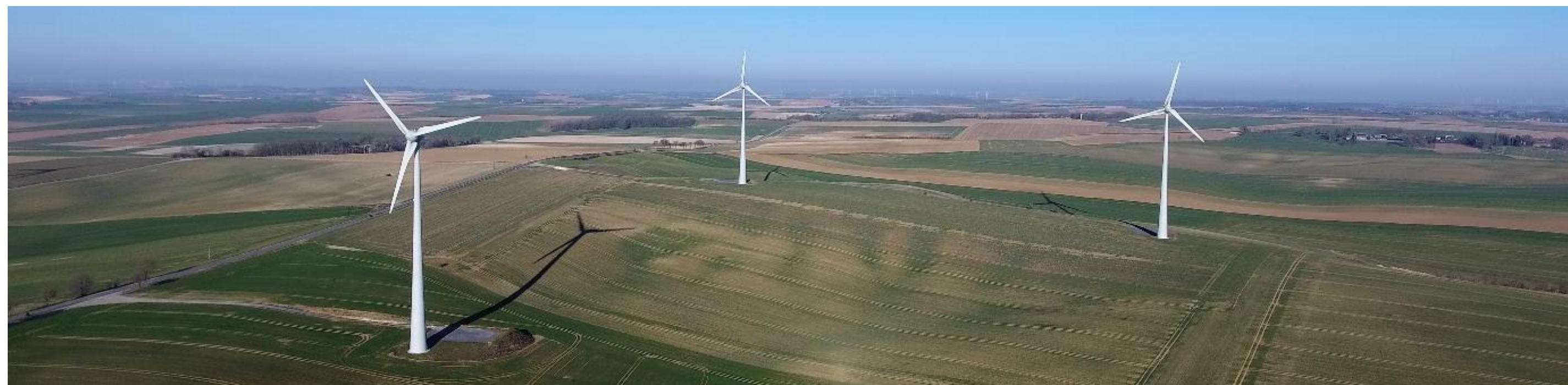
Photo 7 : Parc éolien Quatre Bornes dans le département de l'Aisne, projet porté par wpd (Source : wpd onshore France)
