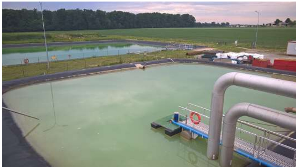
Illustration n° 9 : Vue des bassins bâchés destinés au stockage des eaux géothermales
