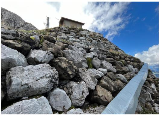
Les massifs de fondation de la gare devront impérativement traverser les remblais de mise à niveau de la plateforme pour solliciter l'assise rocheuse ou les blocs volumineux des terrains de couverture.
