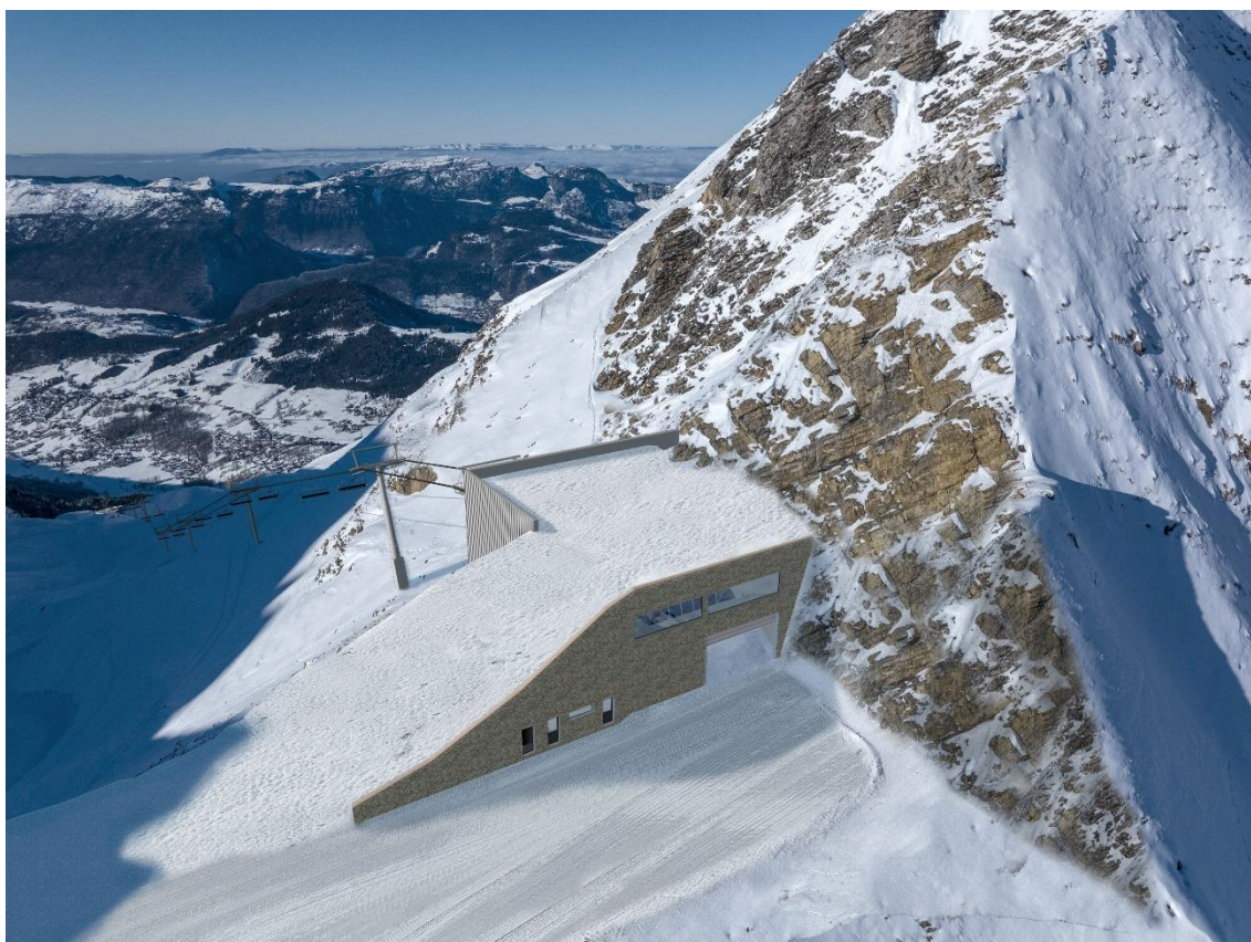
Gare amont en situation hivernale en neige - Source : CNA
