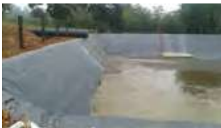
Photo 47 : Fosse en géomembrane (crédit photo : Idele)
