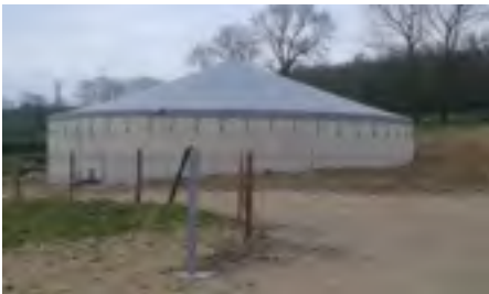
Photo 53 : Fosse circulaire hors-sol couverte (crédit photo : idele)
