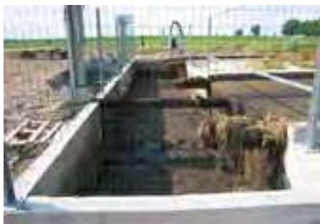
Photo 44 : Pré-fosse rectangulaire en béton (crédit photo : Idele)
