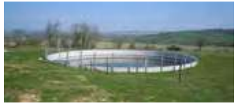
Photo 42: Fosse circulaire enterrée (crédit photo: Idele)
