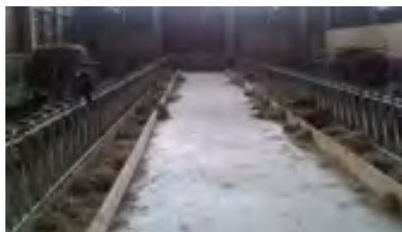
Photo 25 : L'allée d'affouragement centrale, un aménagement classique en bâtiment pour petits ruminants (crédit photo : Idele)
