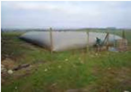
Photo 48 : Poche à effluents liquides (crédit photo : Idele)
