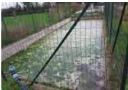
Photo 49 : Un exemple de traitement primaire : le Bassin Tampon Sédimentation (crédit photo : CAHDF)
