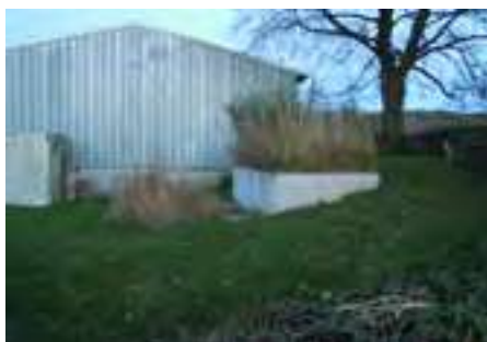
Photo 50 : Filtre planté de roseaux à deux étages (crédit photo : CAHDF)
