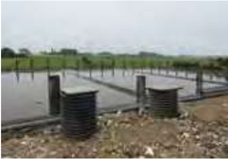
Photo 52 : Lagunage (crédit photo : CAHDF)
