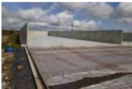
Photo 30 : Silo de stockage des ensilages avec trois murs périphériques en parois auto-stables (crédit photo : Idele)
