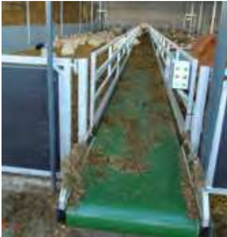
Photo 26 : Le tapis d'alimentation permet la réduction de la largeur du bâtiment (crédit photo : Idele)
