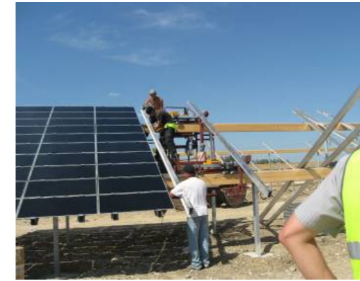
Photographie 7 : Montage de modules sur des supports fixes
