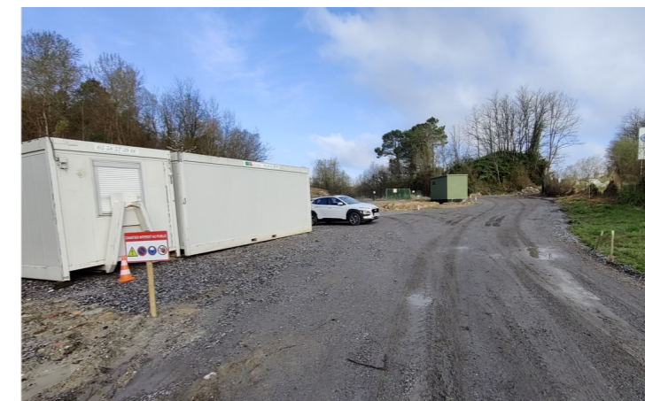
Photographie 4 : Installation de la base-vie
