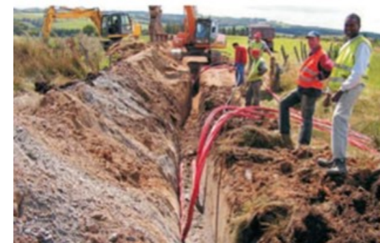
Photographie 8 : Déroulage et pose des câbles (à gauche), exemple de montage d'un poste de conversion (à droite)
