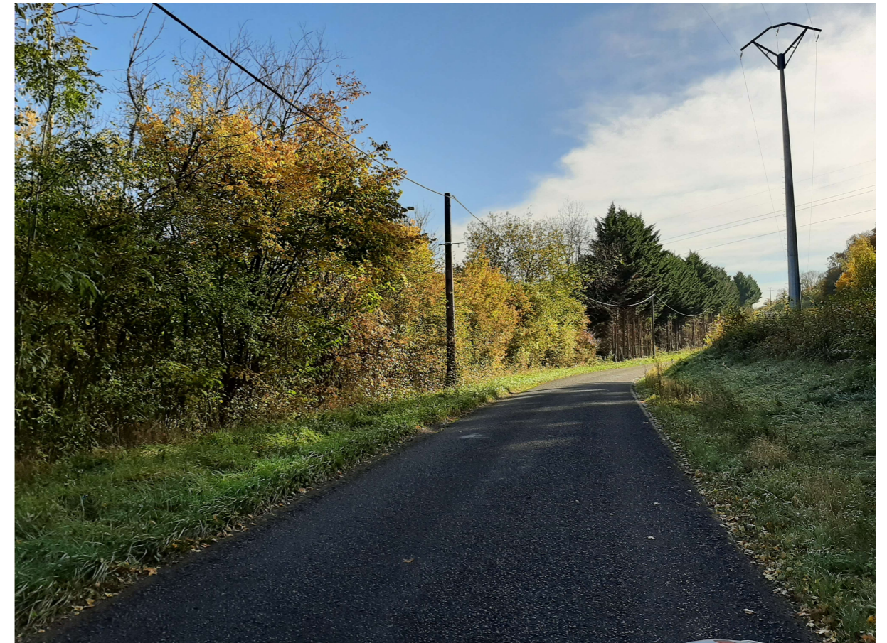
Figure 102: Prise de vue 3 depuis l'Ouest de la zone d'étude
