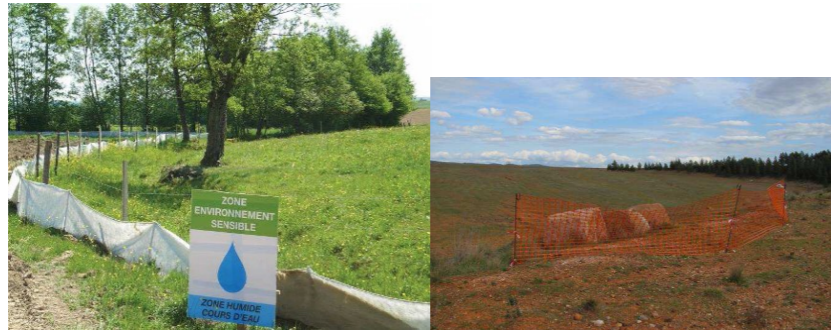
Photographie 5 : Signalétique et balisage (mise en défens) de milieux naturels à enjeux
