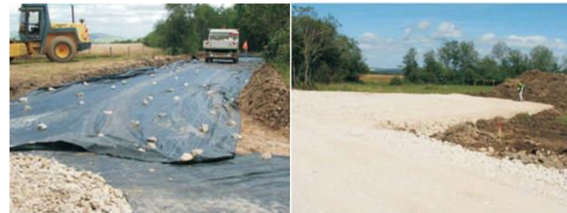
Figure 7 : Exemple de pose d'un géotextile de protection des sols (à gauche), état final d'une plate-forme (à droite)
