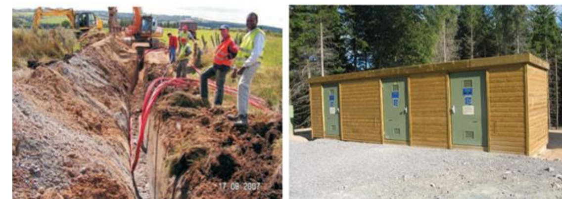
Figure 10 : Exemple de déroulage et pose des câbles (à gauche), poste de livraison (à droite)
