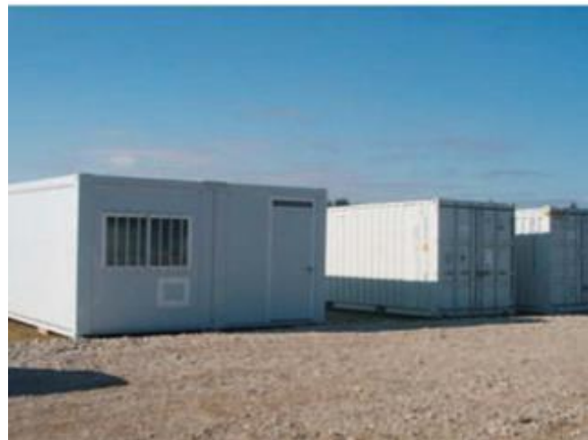
Figure 6 : Exemple d'installation de base-vie
